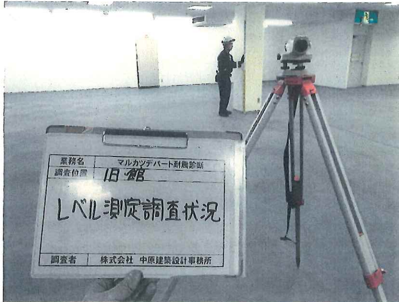
床レベル測定状況
