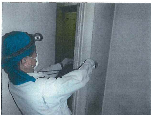
柱寸法調査状況
