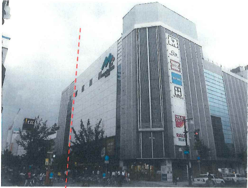
東面 旧館 新館
