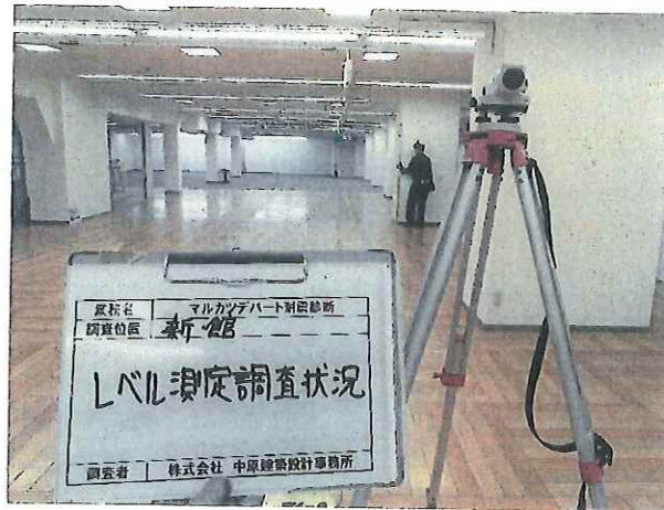
床レベル測定状況
