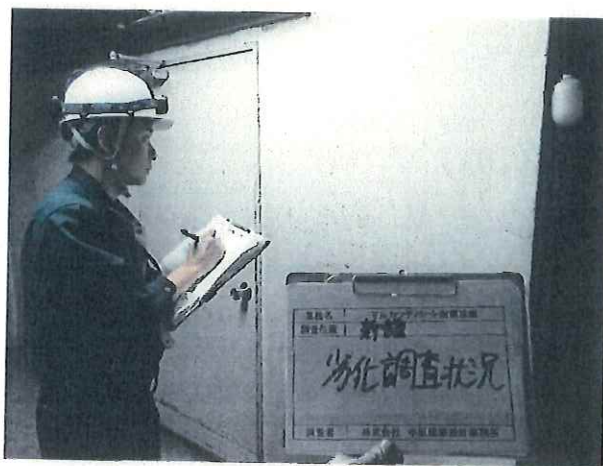
躯体劣化調査状況
